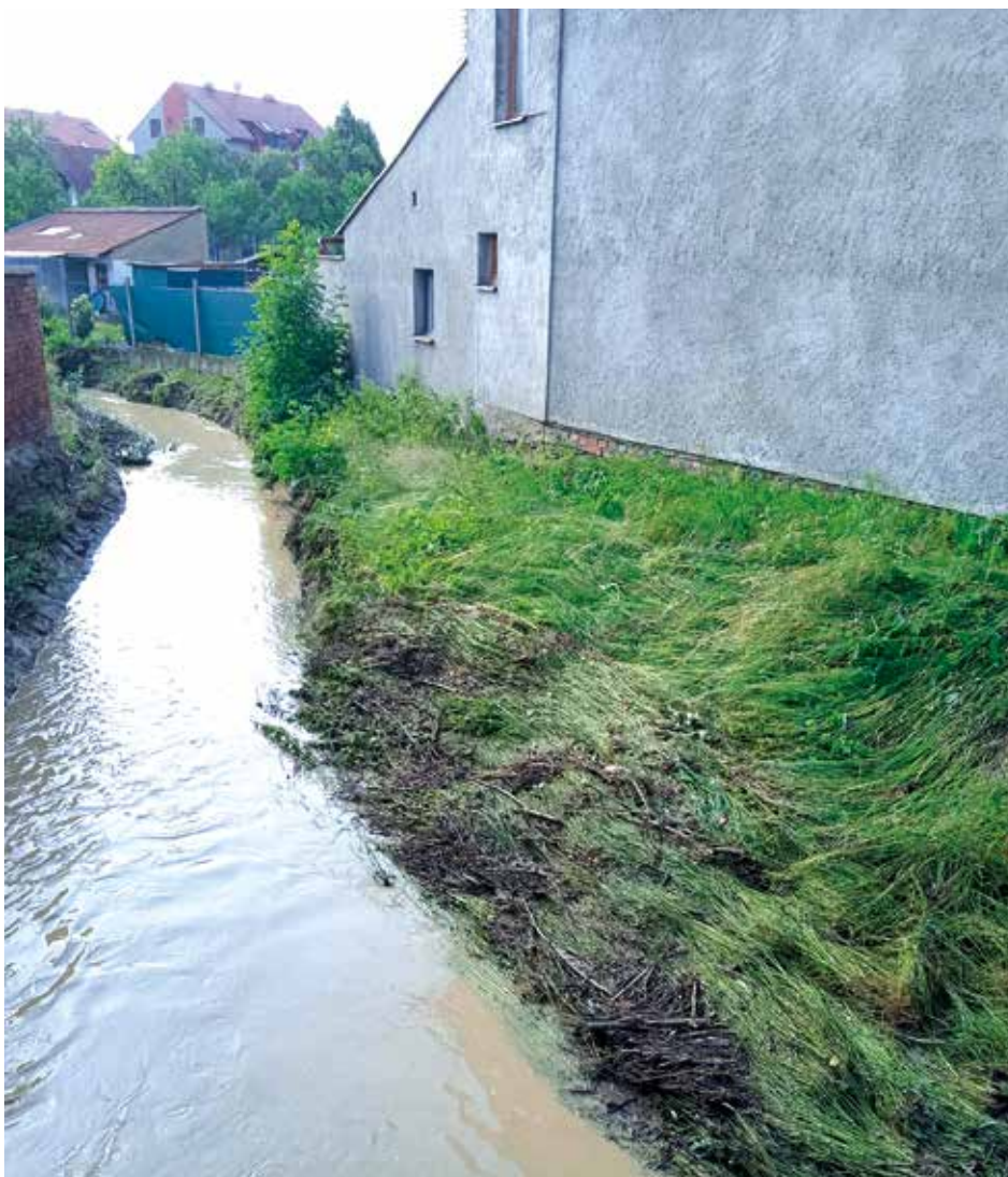
Hladina vody deštěm nebývale vystoupila nejen v Pustiměřském potoku, ale dostala se i do sklepů. Foto: Anna Hrozová.
