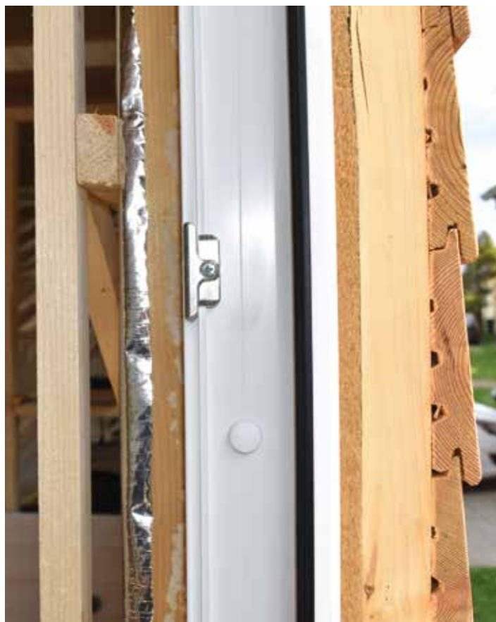
Promyšlená skládaná kombinovaná izolace udržuje v interiéru stálou teplotu. Foto Anna Hrozová.
