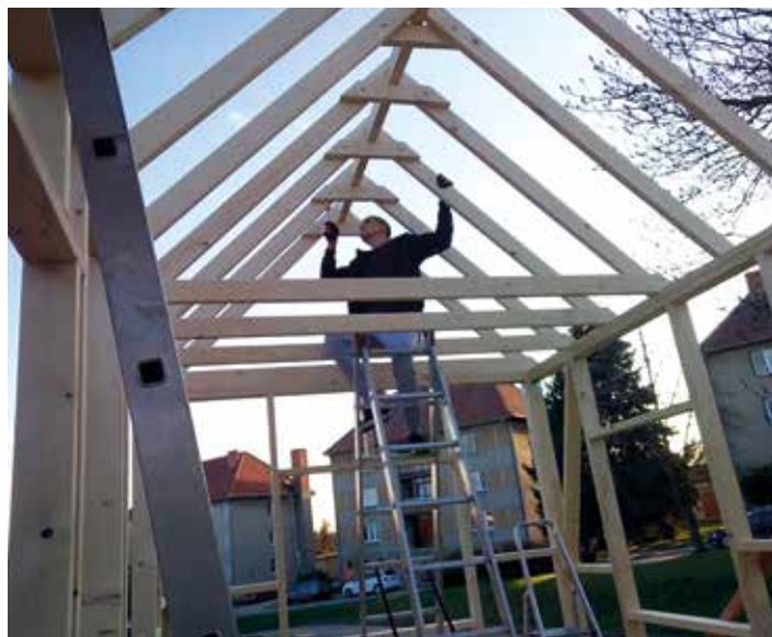
Na podvozku Erik a Pavel Schweidlerovi nejprve postavili pevnou kostru domečku. Zdroj: https://www.facebook.com/TinyHousePustimer .
