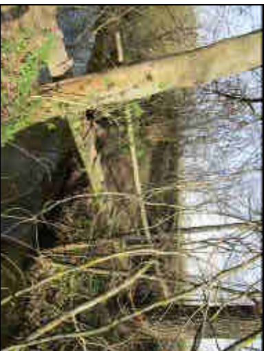
Lávka km 0,0176, pohled proti toku.
