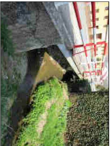
LB zaústění odvodnění pod mostem.
