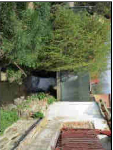
Most km 8,2847, pohled proti toku.
