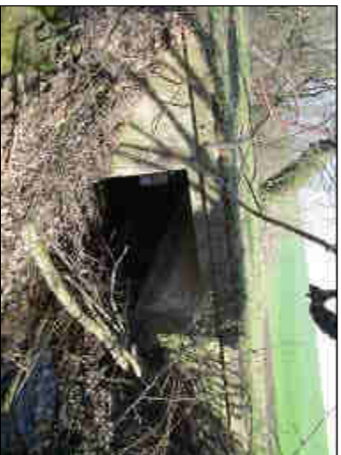
Hospodářský most km 0,8726, pohled proti toku.
