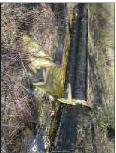
Stupeň na odtoku z jálového přepadu.
