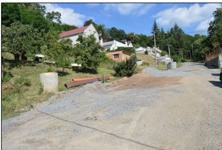
Oprava kanalizace v Buchtále. Foto: Anna Hrozová.
