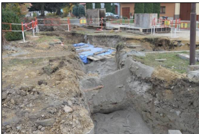
V rohu parku u Adélky je vyhloubena jámka pro přečerpávací stanici. Foto: Anna Hrozová.
