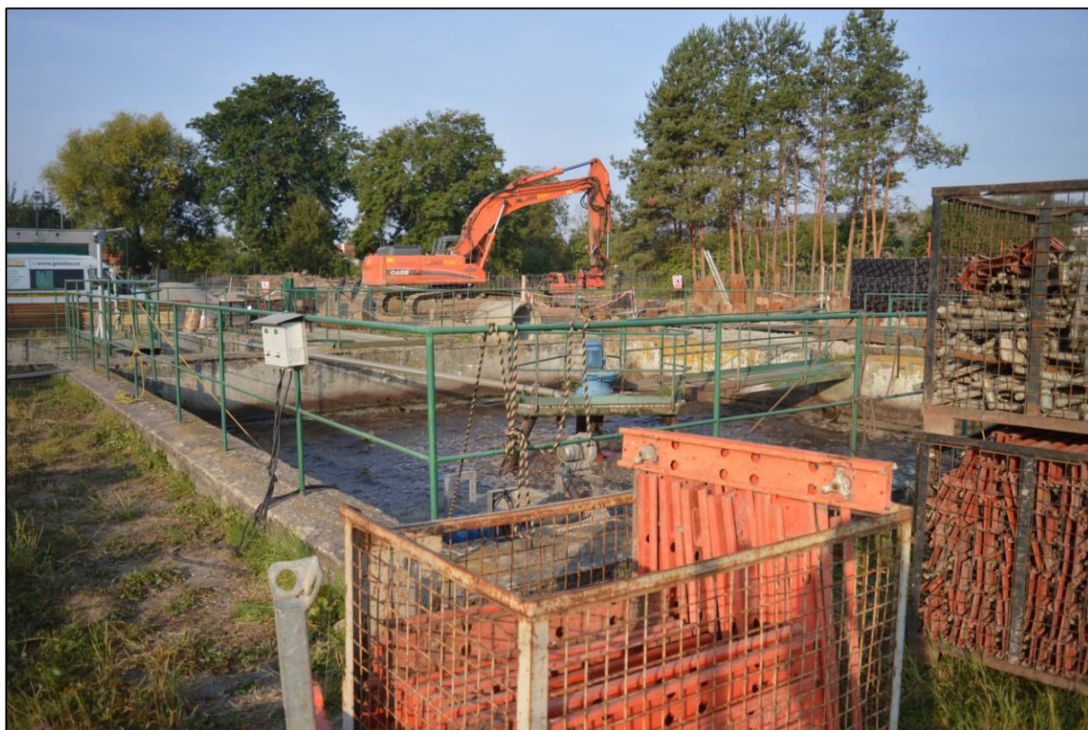
Na čistící stanici panuje čilý stavební ruch. Foto: Anna Hrozová.
