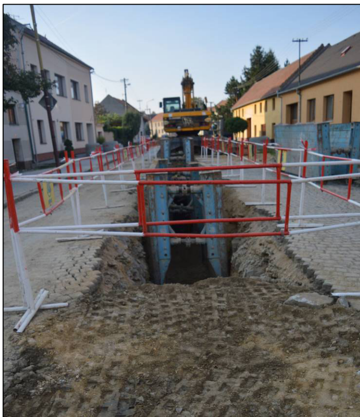
Největší omezení přineslo poskládání nového vedení pod hlavní silnici v Pustiměřských Prusích. Foto: Anna Hrozová.
