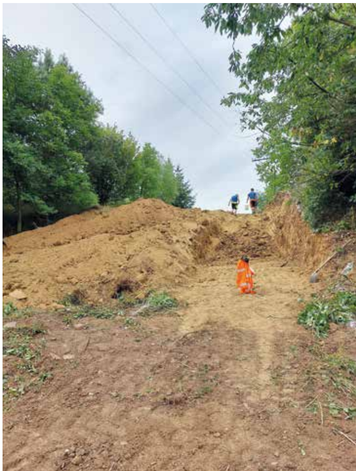
Stavební práce na cyklostezce.
