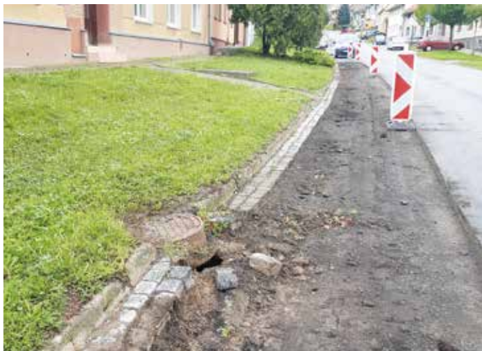
Oprava hlavní silnice u Málkového.
