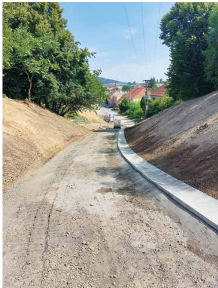
Základní terénní úpravy jsou hotové.
