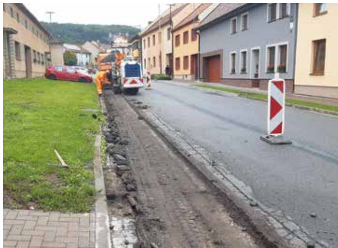
Oprava hlavní silnice v blízkosti nové knihovny.
