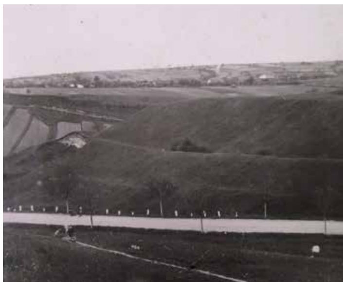
Pohled na naše Hradisko z východu. Dominuje zde ochoz ve stráni z jihu, který byl první obrannou linií fortifikace ostrožny 1964. Zdroj: Muzeum Vyškovska.
