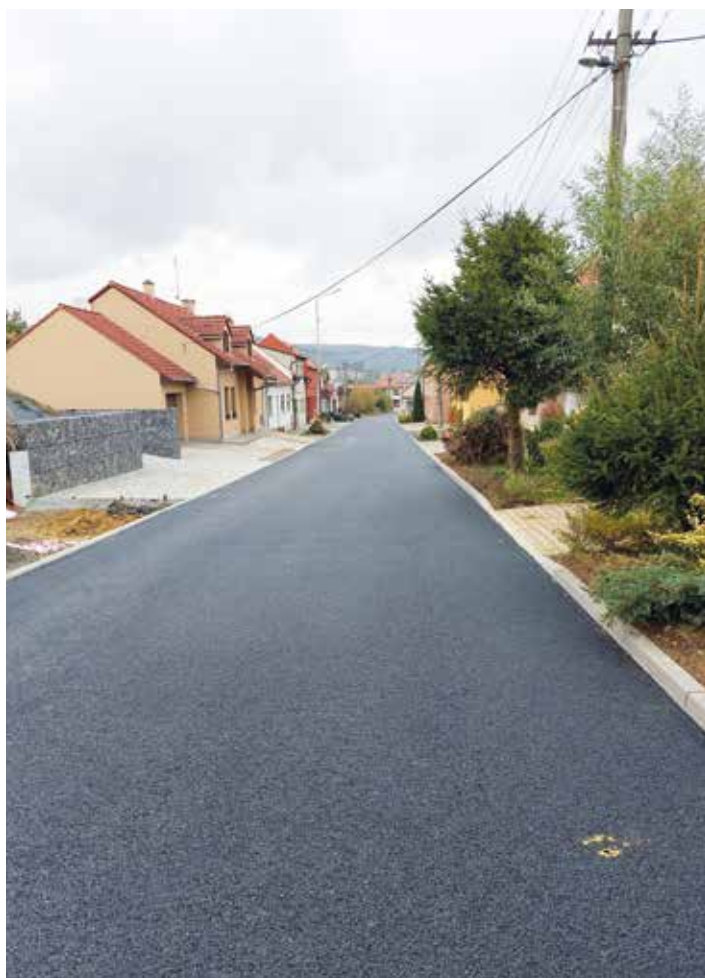
Nová vozovka ve Staré cihelně.
