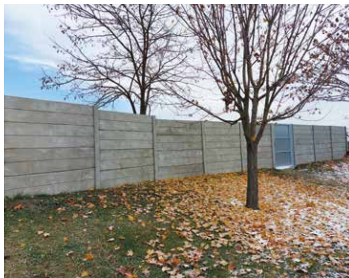
Nové betonové oplocení s brankou.
