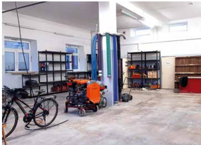
Pohled na opravenou zbrojnici.
