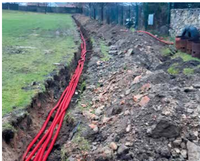
Průběh zemních prací.
