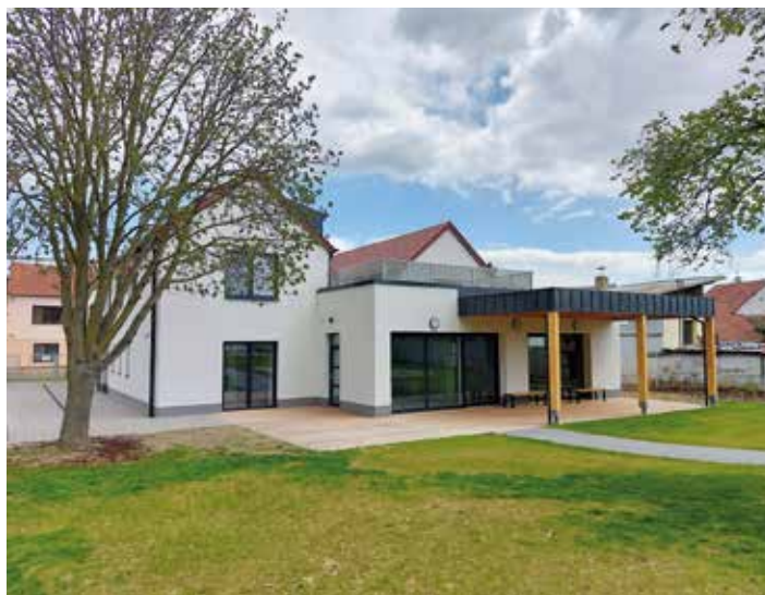
Zadní pohled na budovu po rekonstrukci, rok 2023.
