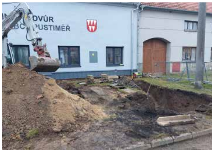
Průběh stavebních prací.
