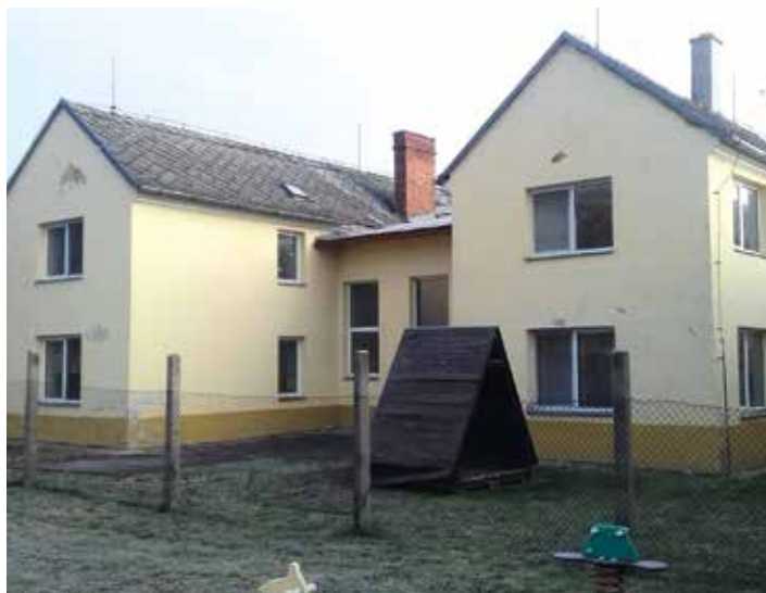
Zadní pohled na budovu před rekonstrukcí, rok 2020.
