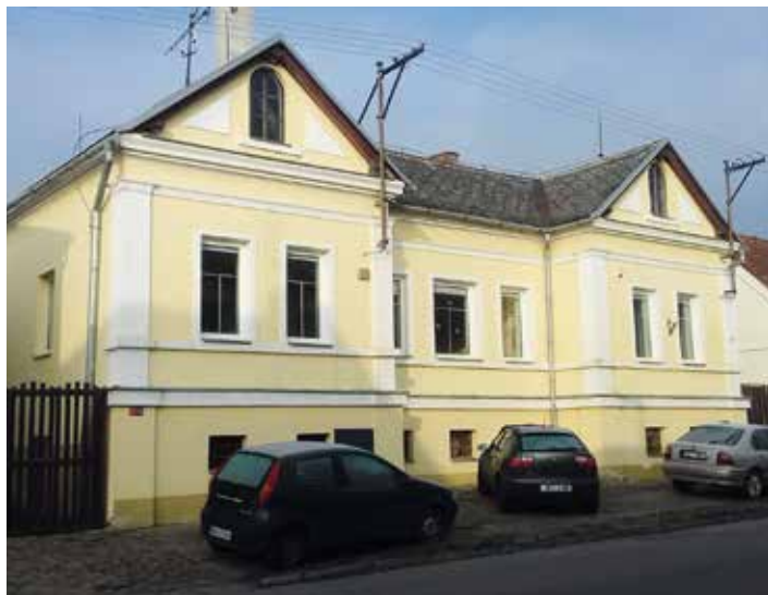
Přední pohled na budovu před rekonstrukcí, rok 2020.
