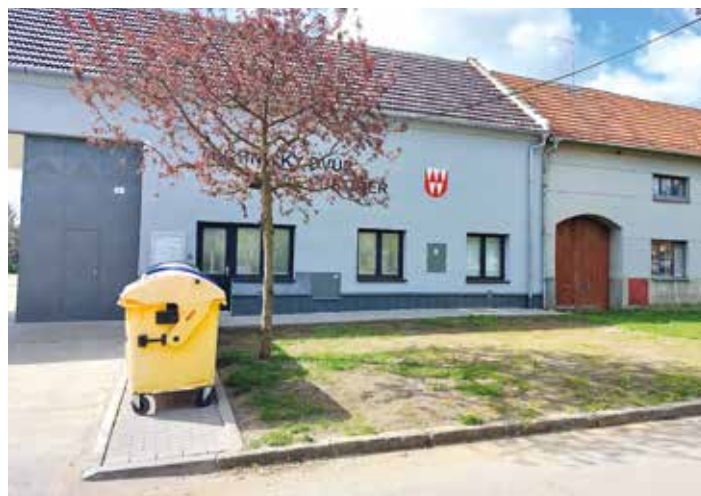
Nový chodník před technickým dvorem obce.
