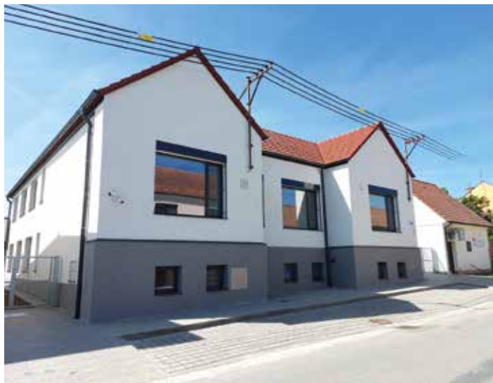
Přední pohled na budovu po rekonstrukci, rok 2023.
